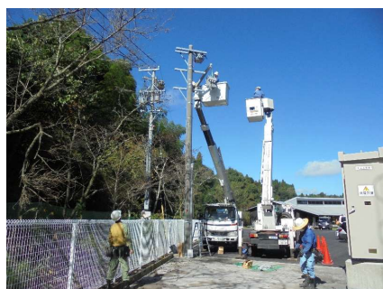
VCTウインチにて吊り上げ
