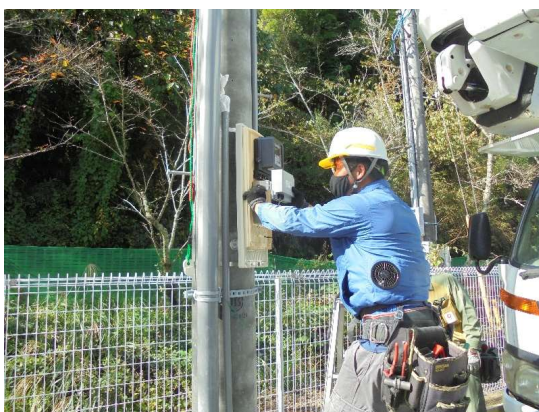
高圧計器取付
