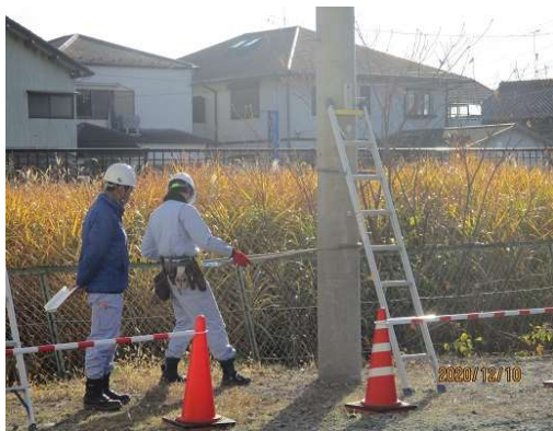
専任班による模擬昇降柱を実施
