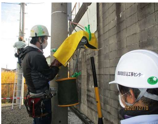
協力店(A・Bランク)による低圧防護取付 (専任班が講師となり実施)
